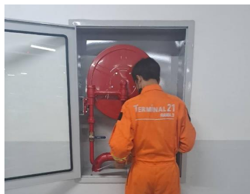
รูปที่ 3-13 การตรวจสอบอุปกรณ์ดับเพลิง
