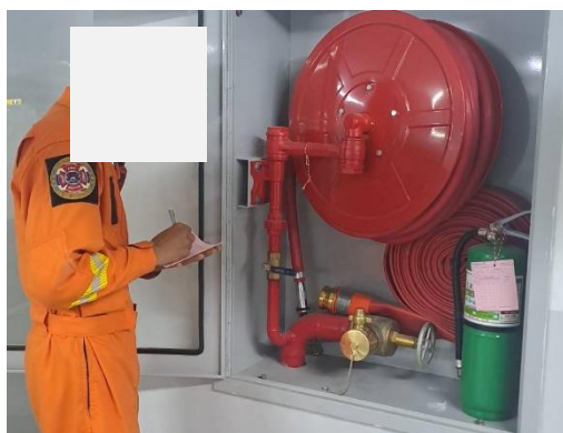
รูปที่ 3-13 การตรวจสอบอุปกรณ์ดับเพลิง
