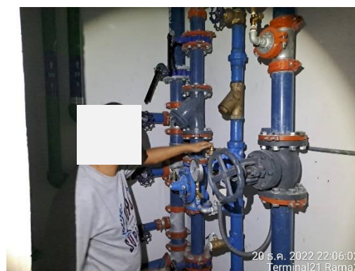
รูปที่ 3-5 การตรวจสอบเส้นท่อประปาและวาล์วควบคุมการจ่ายน้ำ
